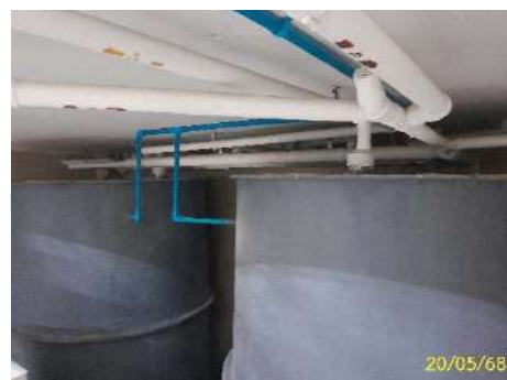
ถังดักละอองฝอย (Aerosol)
